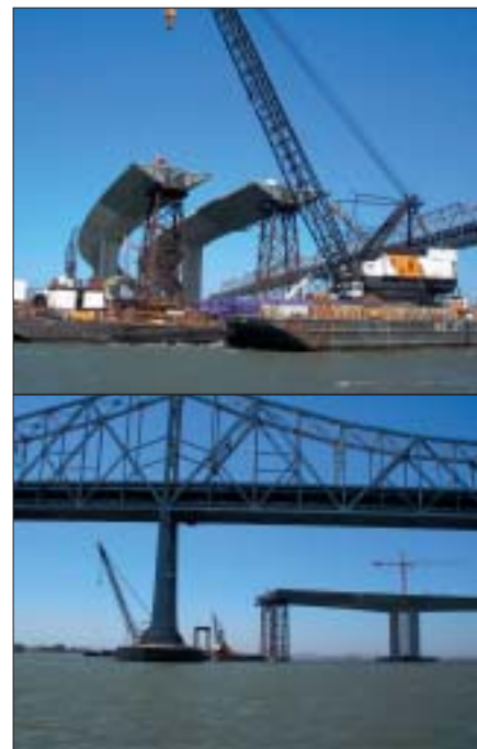
Nowy most Bay Bridge (pełna nazwa San Francisco-Oakland Bay Bridge) nad Zatoką San Francisco, budowany równoległe do starego – jedna z większych inwestycji transportowych w USA, zarządzana przez CALTRANS (California Department of Transportation) – rządową agencję stanu Kalifornia odpowiedzialną za zarządzanie infrastrukturą drogową i transportem publicznym (zdjęcia przekazane przez Autorów).
